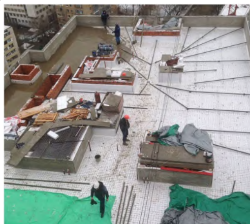
Рис. 6. Капитальный ремонт кровли жилого дома 143 серии по ул. Бендерского восстания 13б
