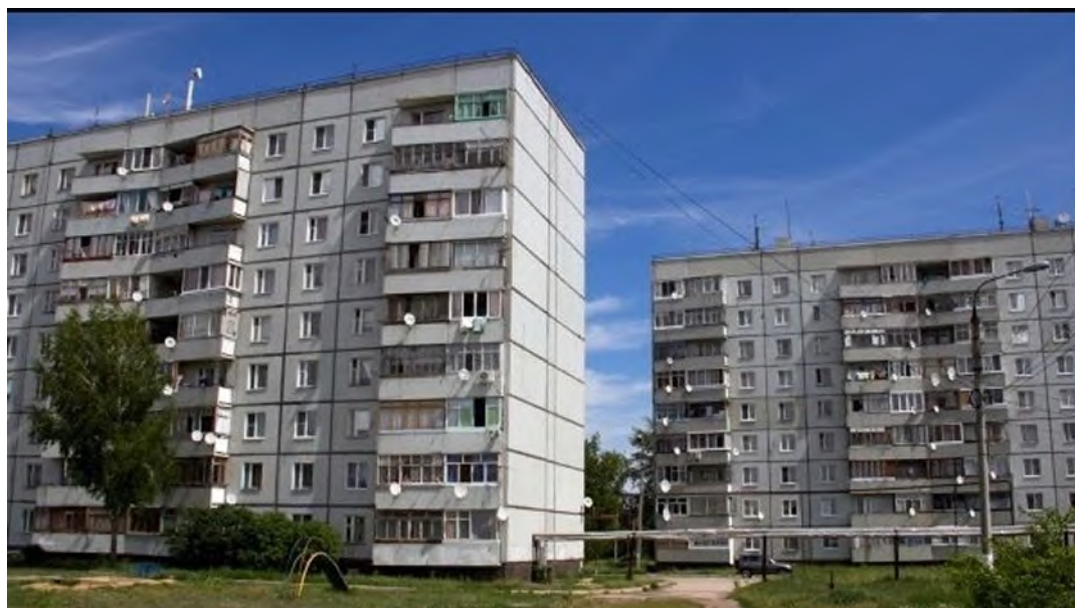
Рис.3. Состояние теплозащиты наружных стен жилых домов по ул. Одесская,18
